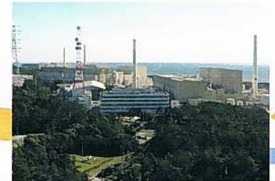
原子力発電所
