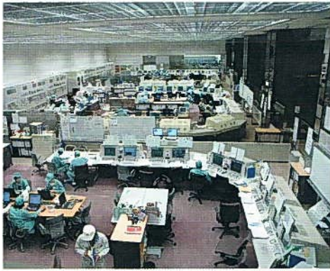
中央制御室 工程ごとに6つのエリアに分けられ、それぞれ10~15人の運転員で運転している
