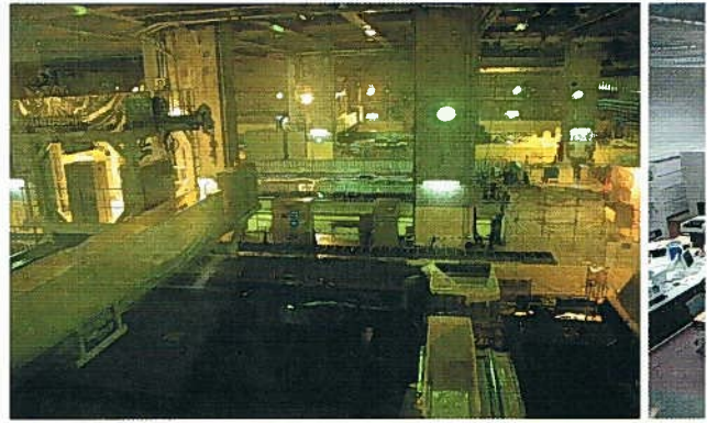
使用済み燃料貯蔵プール 燃料貯蔵プールは燃料種類ごとに1500トンずつ、合計3000トンを貯蔵可能。これは工場の処理能力の3年分以上
